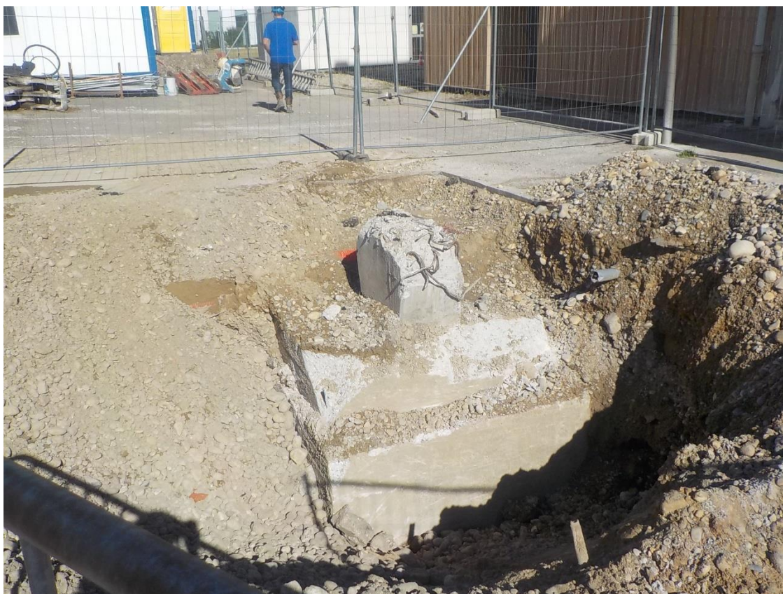
Fondation à démolir (vestige de l'ancienne passerelle déjà démolie) – 2 ouvrages concernés
